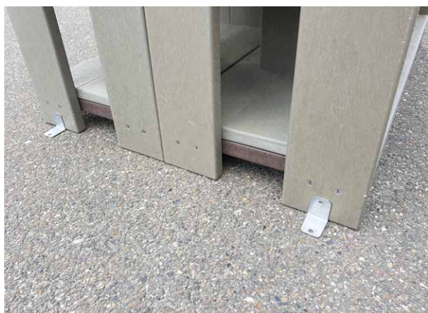
Verankering langs de buitenkant (makkelijkst)
